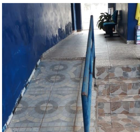
Figura 10: Rampa de acesso para entrada na Biblioteca Comu. Dra. Sandra Nery
