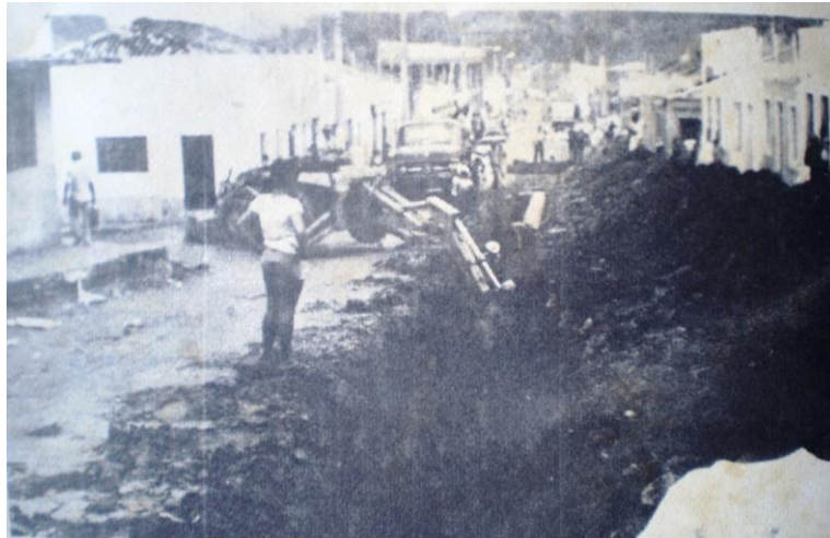
(asfalto e esgoto na Rua Mato Grosso)
