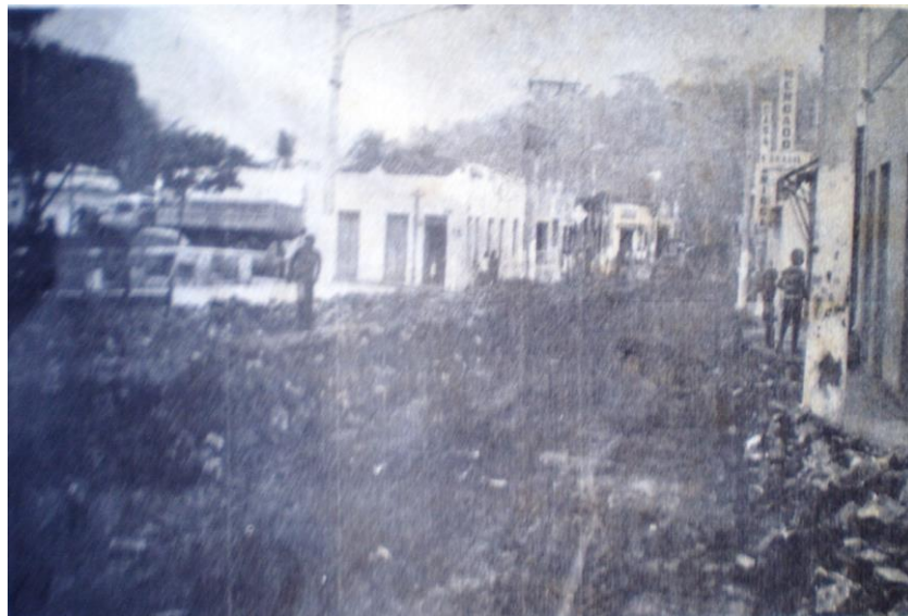
(asfalto e esgoto na Rua Mato Grosso)
